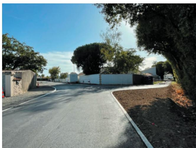
**Nature des travaux :** Mise en œuvre de noue pour infiltrer les eaux sur place. Réfection de la bande de roulement, création de bordures pour la mise en œuvre des trottoirs et création d'un plateau ralentisseur pour marquer le carrefour avec la rue de Saintonge.
